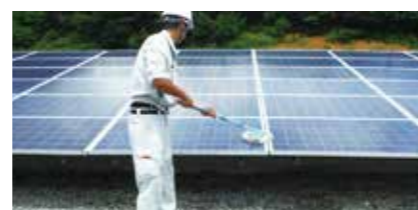
人工洗浄 (工期:5~6日間/MW 4人/日)
