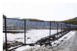
フェンス設置
