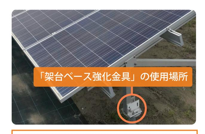
架台ベースを「杭フランジ外周」と 「強化ブラケット」で挟み込み、 2 本の M14 ボルトで追加固定し、 締結強度を増強する。
