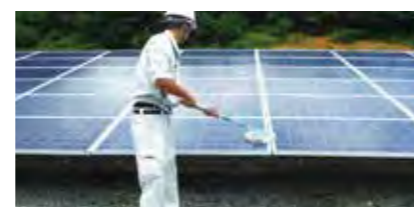
人工洗浄 (工期:5~6日間/MW 4人/日)
