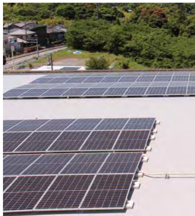
72.96kW | 三重県桑名市
