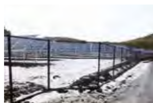
フェンス設置
