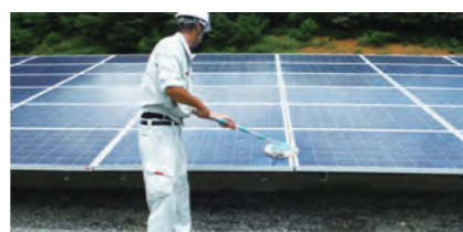
人工洗浄 (工期:5~6日間/MW 4人/日)
