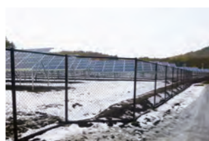
フェンス設置
