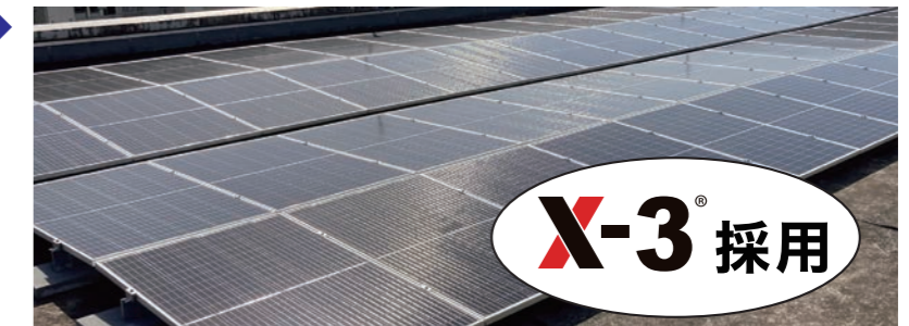
※一部の施設で陸屋根専用架台 X-3 が採用されました。
