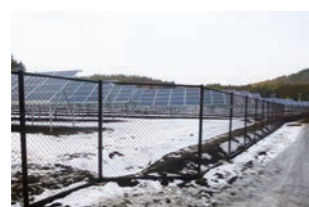
フェンス設置
