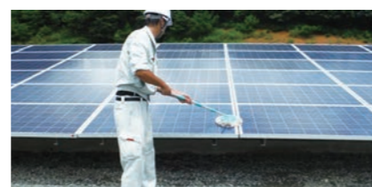
人工洗浄 (工期:5~6日間/MW 4人/日)
