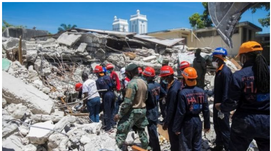
・ハイチ地震での建物倒壊
